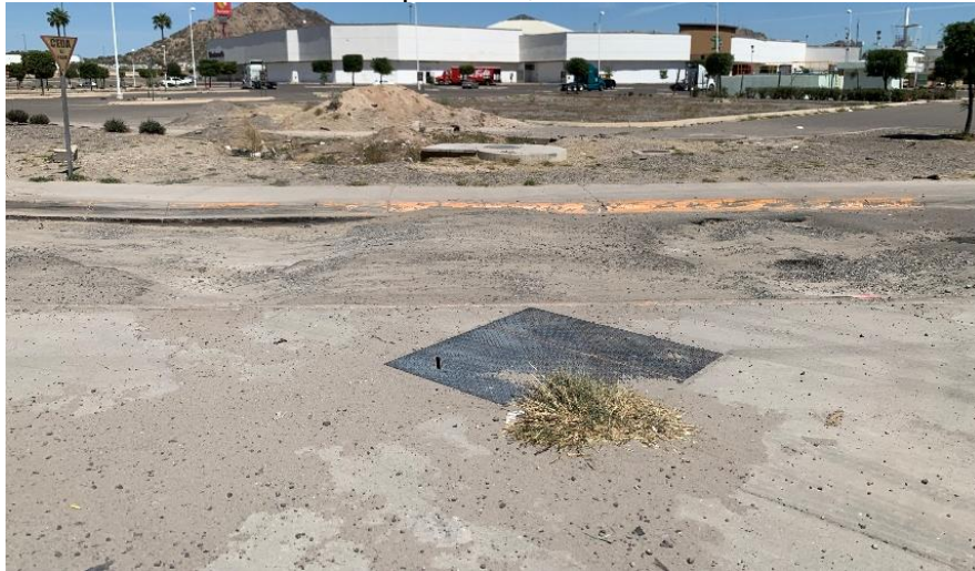
Carril de incorporación, sección noroeste
