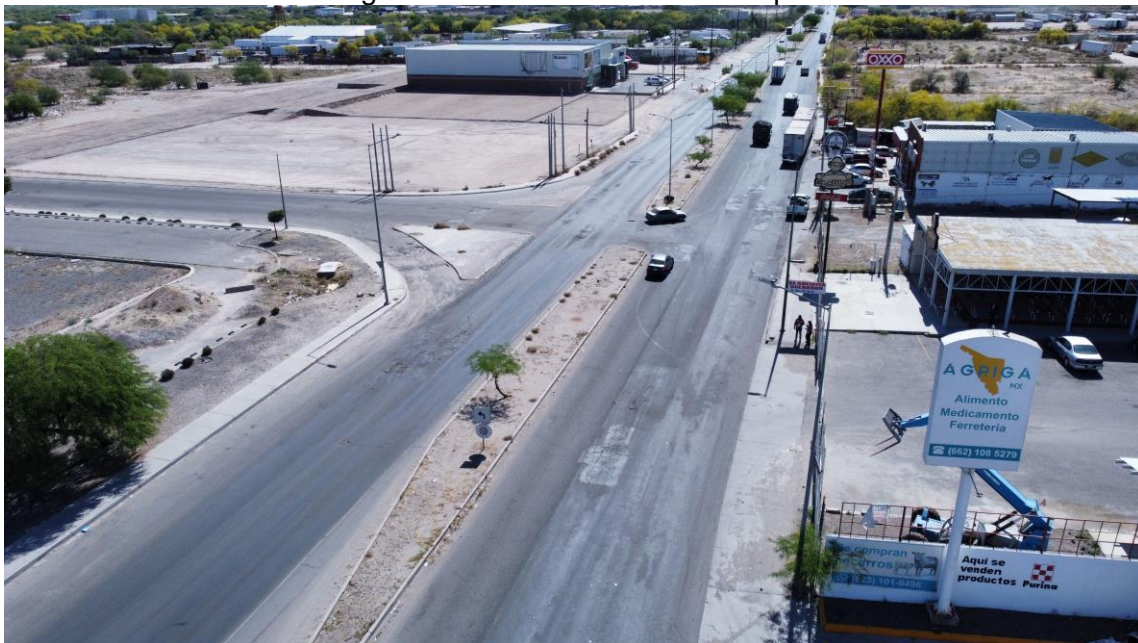
Figura 5.1 Vista aérea del entronque
