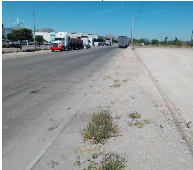
Ausencia de acera, sección noreste
