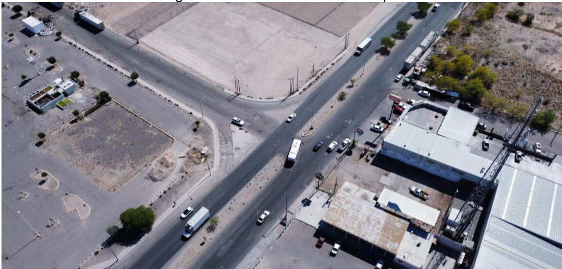
Figura 8.9 Vista aérea del entronque
