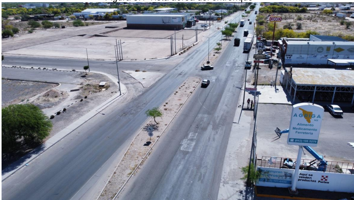
Figura 5.1 Vista aérea del entronque
